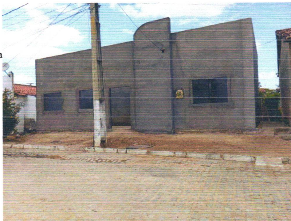
Foto 09 – MASSA ÚNICA, PARA RECEBIMENTO DE PINTURA OU CERÂMICA, ARGAMASSA INDUSTRIALIZADA, PREPARO MECÂNICO, APLICADO COM EQUIPAMENTO DE MISTURA E PROJEÇÃO DE 1,5 M3/H EM FACES INTERNAS DE PAREDES, ESPESSURA DE 5MM, SEM EXECUÇÃO DE TALISCAS. AF_06/2014
